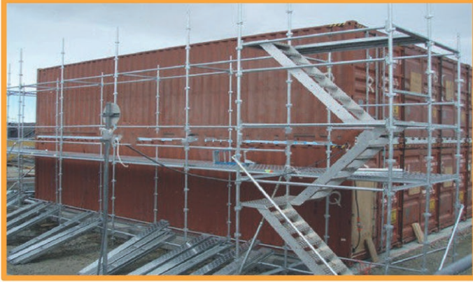
Cephe iskelesi olarak kullanım
