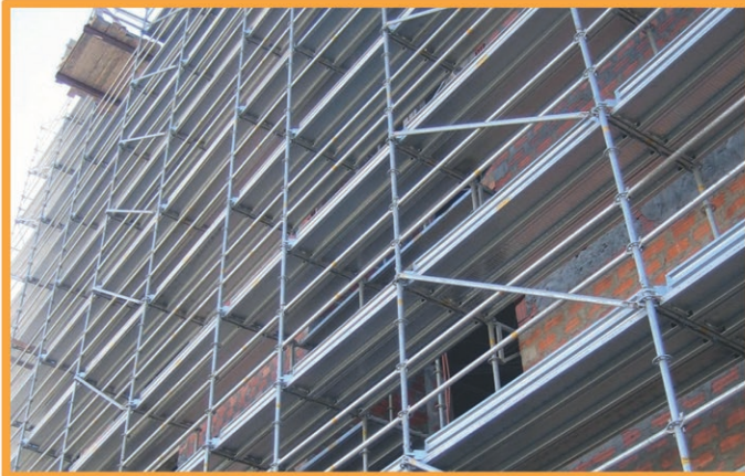
Cephe iskelesi olarak kullanım
